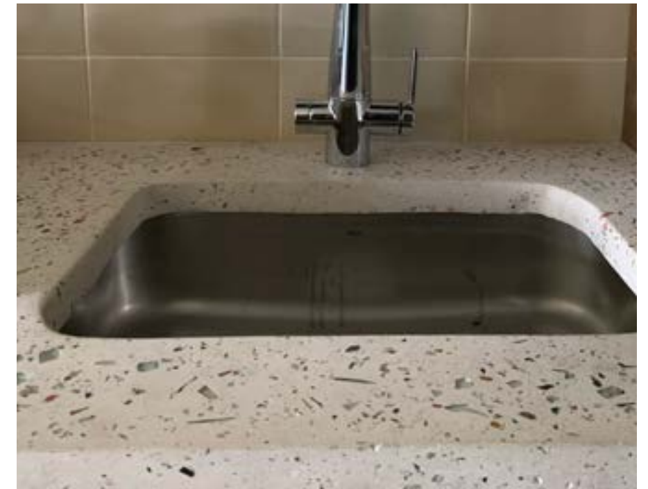
Banheiros e cozinhas equipados com bancadas de granilite feitas a partir de resíduos das demolições internas do Virginia.
