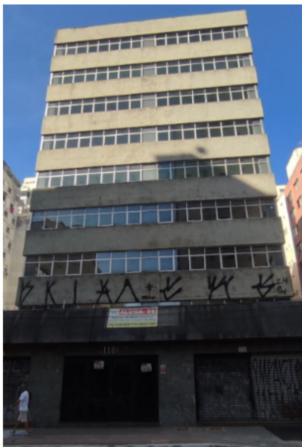
Foto 01 - Foto da fachada do prédio
