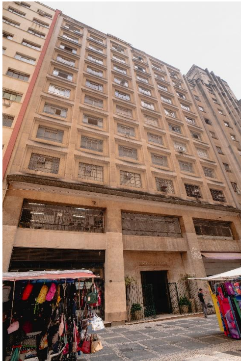
Imagem: Fachada principal do Edifício Anhumas
