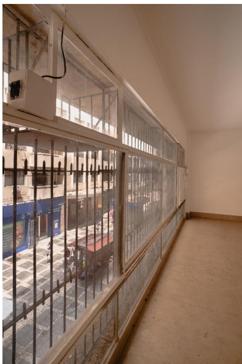
Imagem: Pavimento Sobreloja do Edifício Anhumas
