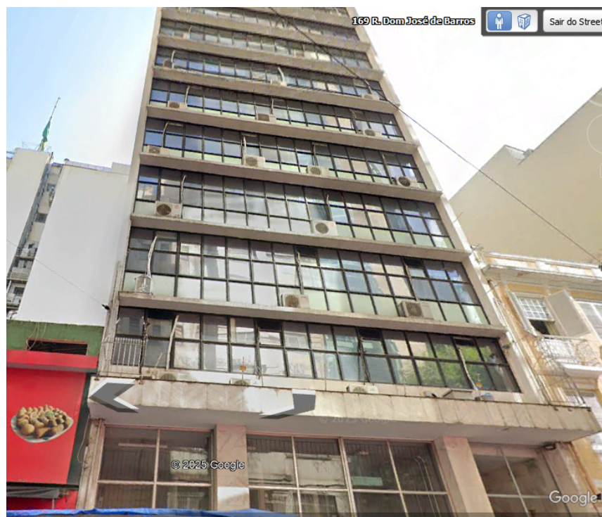
Foto 01 - Foto da fachada do prédio
