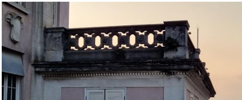
Figura 269 - Guardas-corpos e cimalha com vegetação parasitária, biofilme intenso e sujeidade.
