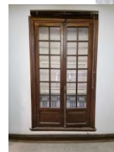
Figura 167 - Esquadria da Sala 27-02 em bom estado.
