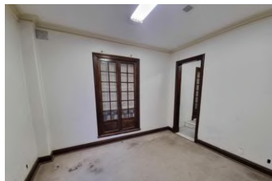
Figura 176 - Vista geral da Sala 27-04 com forro de estuque preservado e demais revestimentos contemporâneos.
