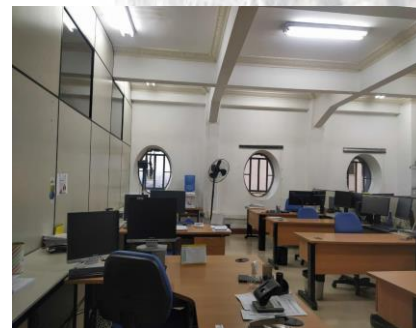
Figura 105 - Mansarda com o uso de escritório com piso vinílico, lucarnas e forro de estuque decorado em bom estado de conservação.
