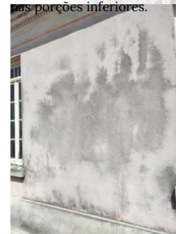
Figura 294 - Biofilme no pano liso.
