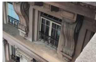
Figura 70 - Biofilme no beiral e biofilme nos ornatos.
