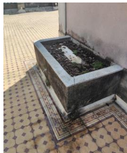
Figura 277 - Vegetação parasitária e biofilme.
