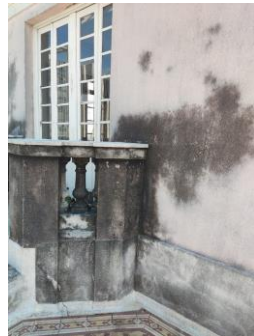
Figura 299 - Biofilme generalizado no guarda-corpo e barrado; concentração em manchas
