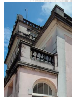
Figura 318 - Guarda-corpos com biofilme.
