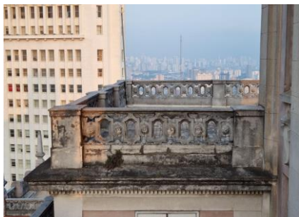
Figura 238 - Guarda-corpos e cimalha com vegetação parasitária, biofilme e sujidade.
