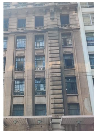
Figura 9 - Concentração de biofilme nas almofadas da coluna e no peitoril das janelas.
