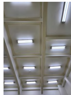
Figura 113 - Detalhe do forro em estuque decorado bicolor em um bom estado de conservação, apesar da espessa camada de tinta.
