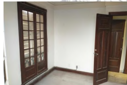
Figura 199- Vista geral da Sala 27-10 com esquadrias em bom estado de conservação.
