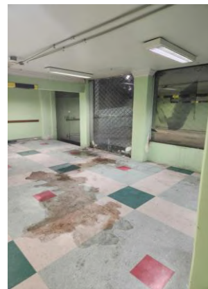
Figura 86 - Nível mais alto da Loja II, localizado no térreo com acesso pela Av. São João.
