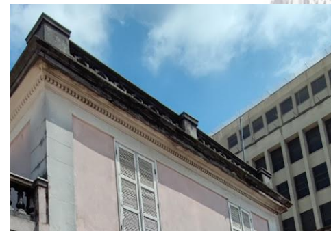
Figura 313 - Vista com biofilme generalizado.
