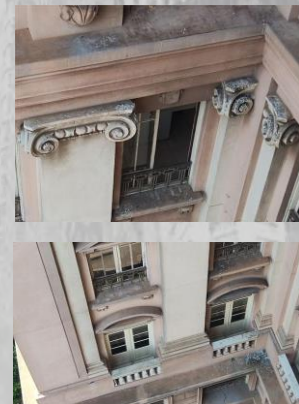
Figura 66 - Sujidade ,(excremento de aves nos ornatos e biofilme na moldura das janelas.
