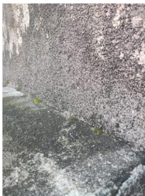
Figura 304 - Revestimento deslocado, substrato exposto e com fissuras.
