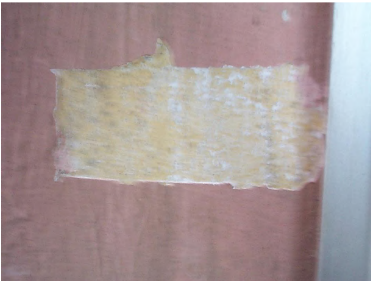
Figura 17 - Cor em tom ocre encontrada na ilharga da janela da fachada dos fundos. Fonte: Acervo Estúdio Sarasá.
