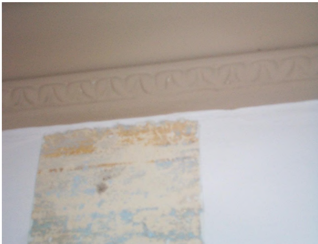
Figura 9 – Prospeção A5 em parede do escritório do 27º pavimento com faixas e filetes com motivo decorativo simples (forro e rodadeto descaracterizados). Fonte: Acervo Estúdio Sarasá.
