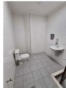
Figura 184 - Sanitários contemporâneos com revestimento cerâmico no piso e paredes em bom estado.
