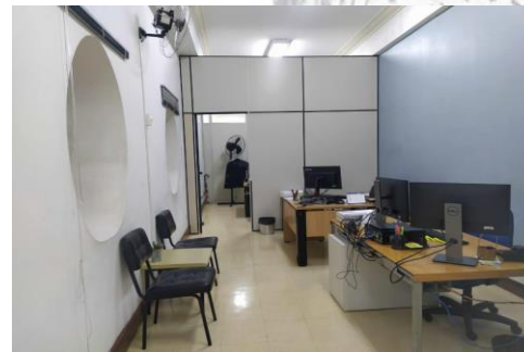
Figura 109 - Divisão dos ambientes com divisórias navais.
