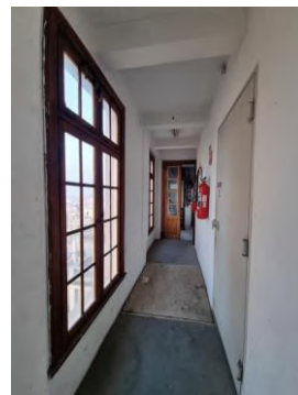
Figura 233 - Vista do Corredor 28-04.
