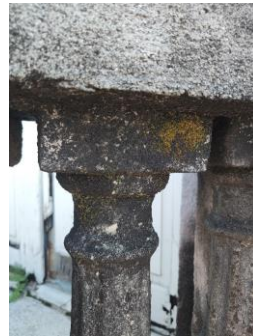
Figura 300 - Biofilme generalizado e pontos de vegetação parasitária no balaústre.
