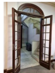
Figura 154 – Esquadria de madeira e vidro da Sala 26-07 em bom estado.
