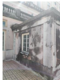
Figura 337 - Biofilme generalizado.
