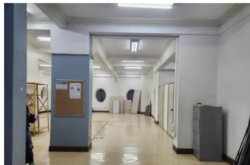
Figura 112 - Piso vinílico, panos lisos e forro em estuque decorado bicolor.
