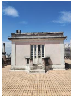
Figura 281 - Vista geral da elevação.
