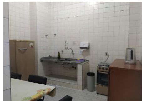
Figura 117 - Vista geral da copa com revestimentos cerâmicos.
