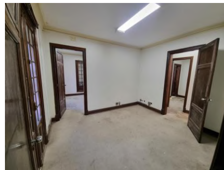
Figura 171 - Pontos de infiltração, formação de biofilme e desprendimento de pintura no teto e paredes da Sala 27-03.
