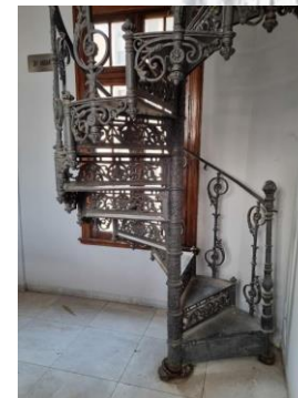
Figura 228 - Escada caracol de ferro fundido decorada em bom estado de conservação.
