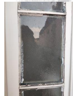
Figura 332 - Massa de vidro ressecada e vidro com manchas de tinta.
