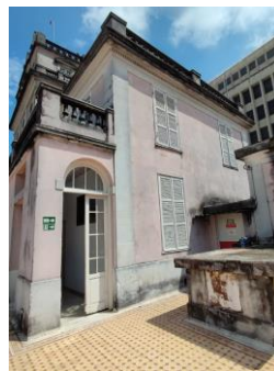
Figura 312 - Vista geral da elevação.
