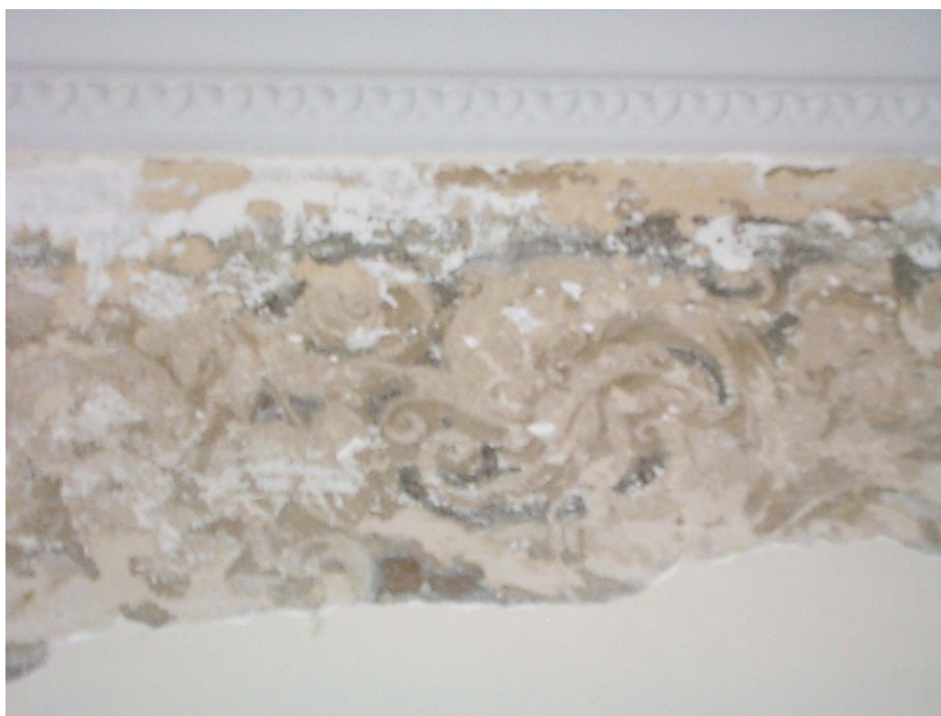
Figura 8 – Prospeção A4 realizada na caixa de escada com faixa decorativa com motivos fitomórficos e detalhes com tinta dourada (hoje oxidada e com coloração esverdeada). Fonte: Acervo Estúdio Sarasá.
