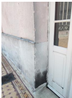
Figura 321 - Concentração de biofilme no requadro.
