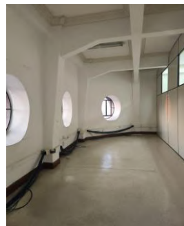
Figura 101 - Lucarnas vistas da parte interna.
