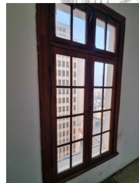
Figura 234 - Face interna da janela em bom estado de conservação.
