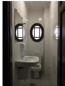
Figura 202 - Vista geral da Sala 27-11 com revestimentos contemporâneos no piso e parede em bom estado.
