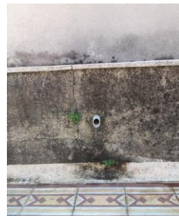
Figura 278 - Vegetação parasitária e biofilme.
