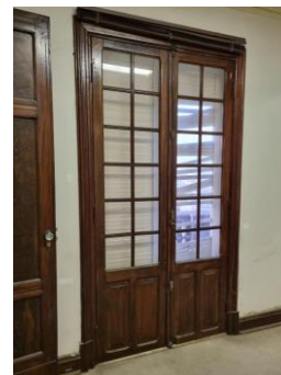
Figura 172 - Folha interna da Porta janela da Sala 27-03 em bom estado.
