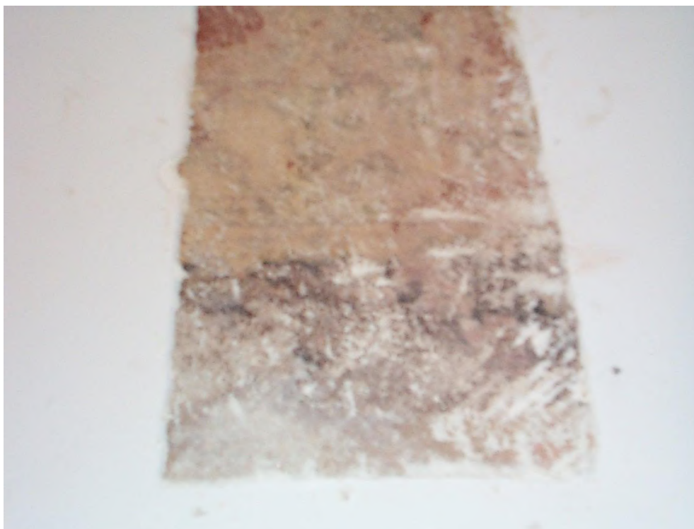
Figura 6 – Prospecção A2 em parede da Sala 1 da Fig.1 encontrando pintura decorativa com faixas de motivos fitomórficos. Fonte: Acervo Estúdio Sarasá.
