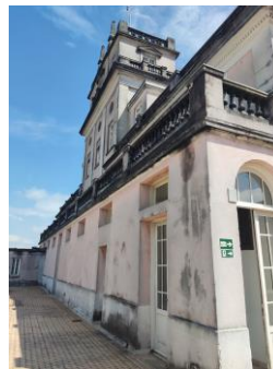
Figura 319 - Vista geral da elevação.
