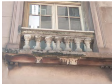
Figura 44 - Formação de biofilme e desprendimento
