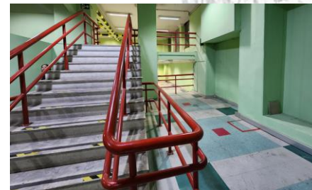
Figura 92 - Escada em bom estado de conservação.
