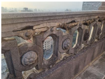
Figura 249 - Lacunas no guarda-copo, exposição de armadura e presença de biofilme.
