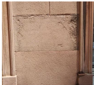
Figura 49 - Desgaste do revestimento e biofilme
