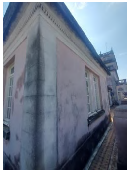
Figura 344 - Biofilme no barrado, cimalha e quina.
