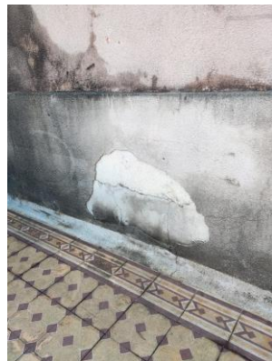
Figura 304 - Revestimento deslocado, substrato exposto e com fissuras.
