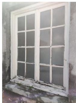
Figura 336 - Biofilme generalizado no peitoril e panos lisos; deslocamento de pintura generalizado; vegetação parasitária na pingadeira.
