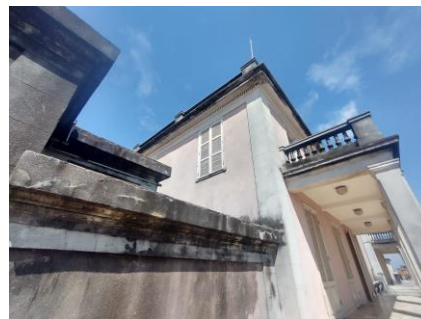
Figura 366 - Biofilme nas cimbalhas e lacunas no revestimento.
