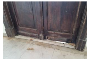
Figura 133 - Esquadrias de madeira, onde nota-se o ressecamento pela ação do tempo.
