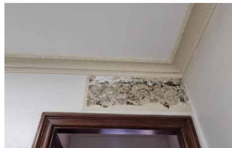
Figura 207 - Prospecção pictórica na parede da Circulação 27-12 expondo pintura decorativa.
