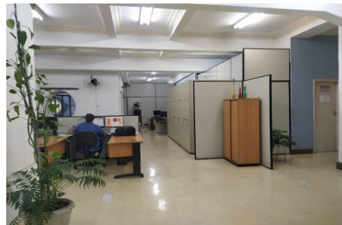
Figura 107 - Mansarda com forro em estuque decorado bicolor em bom estado de conservação e demais revestimentos contemporâneos. Divisórias navais subdividindo as salas..
