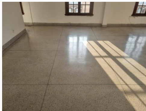
Figura 159 - Piso em granilite em bom estado.
