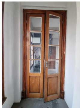
Figura 235 - Porta do Corredor 28-04 em bom estado de conservação.
