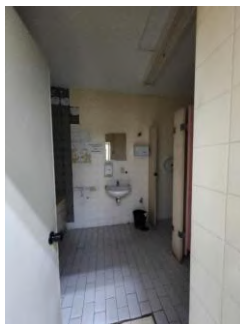
Figura 115 - Sanitário com revestimentos cerâmicos e forro de gesso acartonado.
