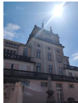
Figura 334 - Cobertura completa de biofilme sobre guarda-corpos e cimalhas.
