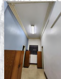
Figura 114 - Corredor de acesso ao sanitário e copa..
