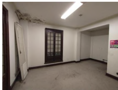
Figura 218 - Vista geral da Sala 27-15.
