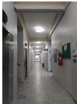
Figura 100 - Corredor com piso de mármore em bom estado de conservação e forro em estuque decorado bicolor.
