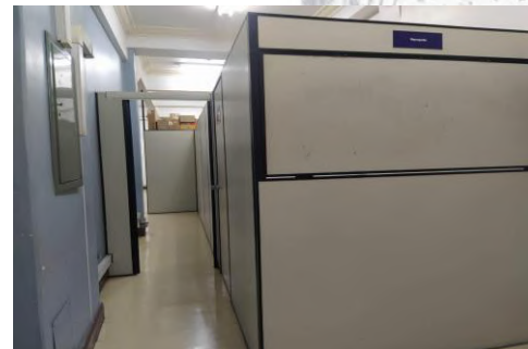
Figura 123 - Divisórias navais e forro em estuque decorado.
