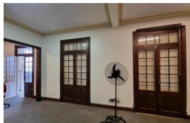
Figura 153 – Piso contemporâneo cimentício, forro de estuque e paredes com pintura na cor branca e esquadrias em bom estado de conservação.
