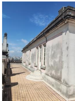
Figura 288 - Vista geral da elevação.
