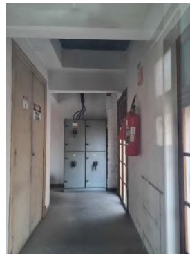
Figura 224 - Vista geral da Sala 27-19 com piso cimentício, teto e paredes com pintura na cor branca.
