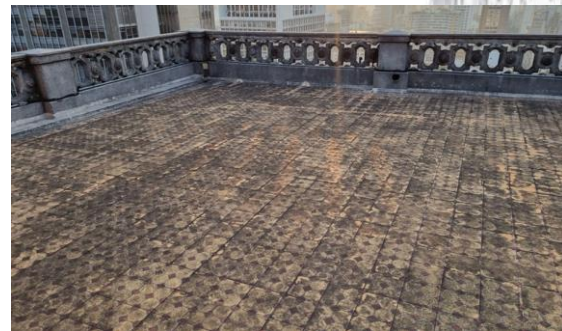
Figura 268 - Ladrilhos hidráulicos com peças desgastadas e escurecidas.
