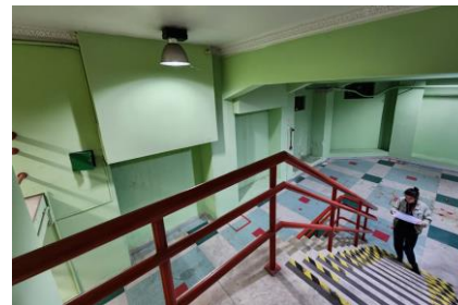
Figura 88 - Escada com revestimento em mármore para acesso ao segundo nível abaixo.
