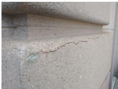
Figura 13 - Fissura nas extremidades da almofada indicando processo de desprendimento do revestimento.
