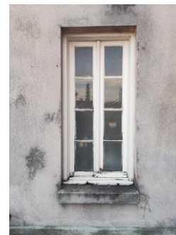
Figura 331 - Pingadeira em madeira com lacunas e biofilme, biofilme no peitoril.
