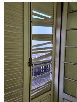
Figura 174 - Folha externa do tipo veneziana com perdas de inúmeras peças.
