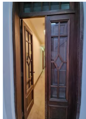
Figura 162 - Porta de madeira da Circulação 27-01 em bom estado de conservação.
