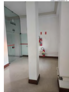
Figura 104 - Entrada do ambiente. Piso vinílico e rodapé de madeira.
