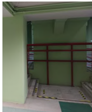
Figura 95 - Escada de acesso ao terceiro nível abaixo da Loja 11, com revestimento em mármore.
