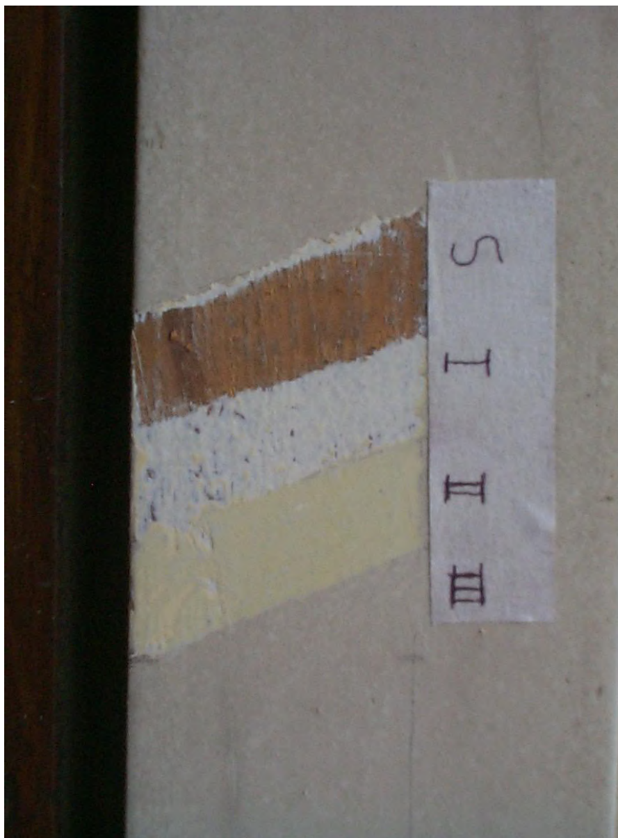
Figura 14 – Prospecção B4 na Sala 184, Fachada da Rua São Bento. Fonte: Acervo Estúdio Sarasá.
