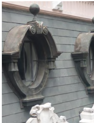
Figura 21 - Corpo central da moldura em processo de oxidação e com enxertos em material diferente da substrato original.
