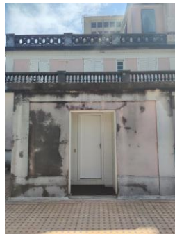
Figura 333 - Cobertura completa de biofilme sobre guarda-corpos; manchas esparsas sobre panos lisos.
