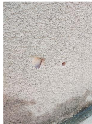
Figura 304 - Revestimento deslocado, substrato exposto e com fissuras.
