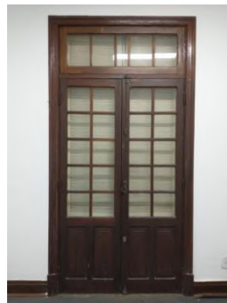
Figura 143 - Porta de madeira em bom estado de conservação.
