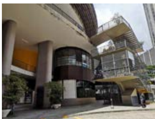
Imagens do acesso principal e terraços do embasamento do edifício Copan.
