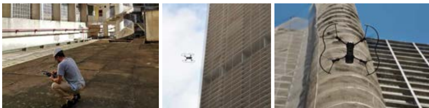
Imagens do levantamento de varredura das fachadas por DRONE. Fonte: Instituto Pedra
