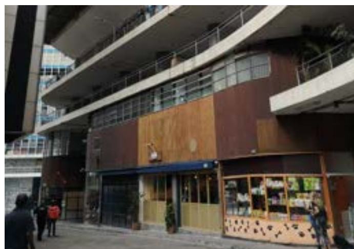
Fechamentos incompatíveis com o projeto da Fachada nas lojas no piso térreo. FONTE: Instituto Pedra.
