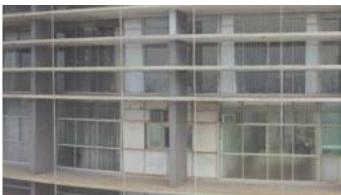
Fechamentos foscos na caixilharia e presença de aparelhos de ar condicionado na Fachada Norte, 23º andar do Bloco D. FONTE: Drone Way/Instituto Pedra.
