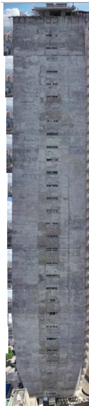
Fotomontagem e mapa de danos da empena Sudoeste, realizada com as cenas geradas a partir da filmagem com drone. FONTE: Drone Way/Instituto Pedra.
