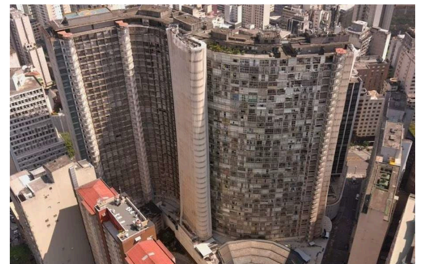
Fonte: Manual de Conservação (Concrejato, 2025)
