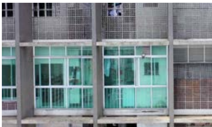
Substituição dos cobogós da Fachada Sul por caixilharia com vidro, no 25º andar do Bloco C. FONTE: Drone Way/Instituto Pedra.
