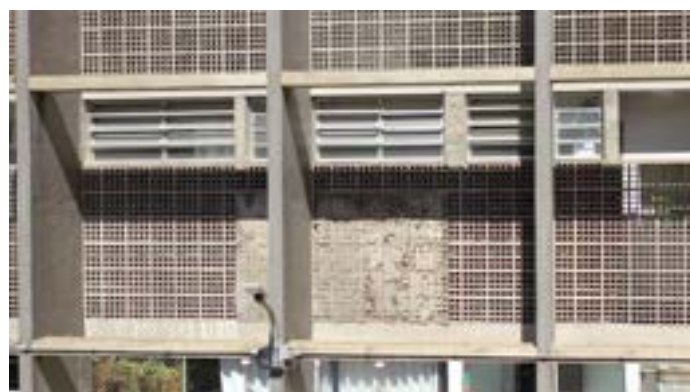
Fechamento dos cobogós com reboco no 2º andar do Bloco E. FONTE: Drone Way/Instituto Pedra.
