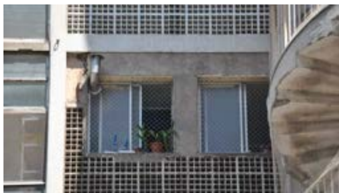
Substituição dos cobogós da Fachada Sul por caixilharia de alumínio. FONTE: Drone Way/Instituto Pedra.
