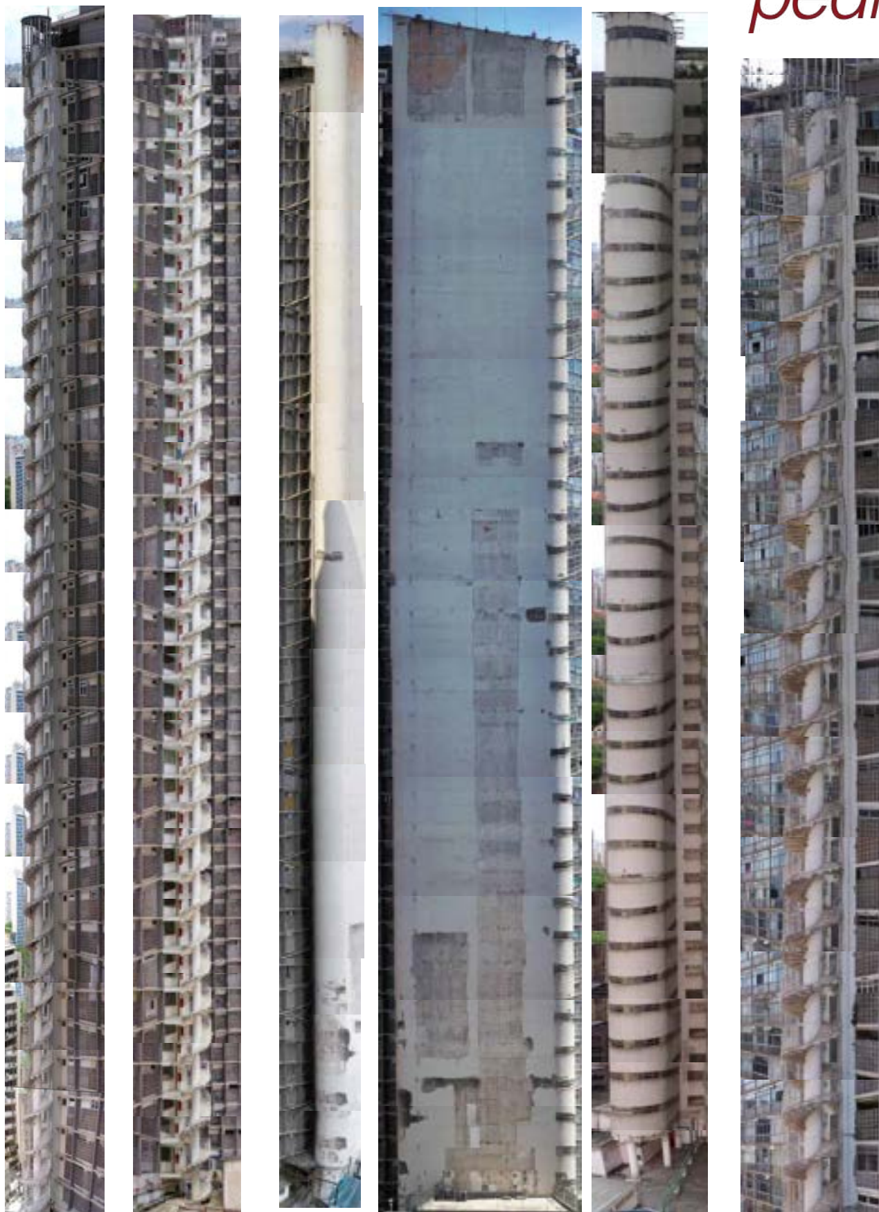
Fotomontagens das escadas da Fachada Sul, realizadas a partir das cenas geradas mediante filmagem com drone. FONTE: Drone Way/Instituto Pedra.
