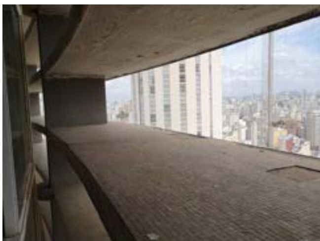
Imagens do brise-soleil e seus elementos estruturais na fachada Norte do edifício Copan. FONTE: Instituto Pedra
