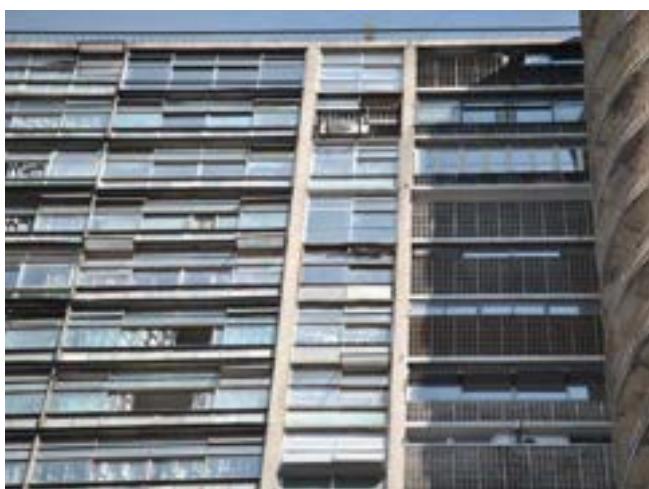
Imagens dos diferentes tipos de vedação encontrados na fachada Sul do edifício Copan. FONTE: Instituto Pedra
