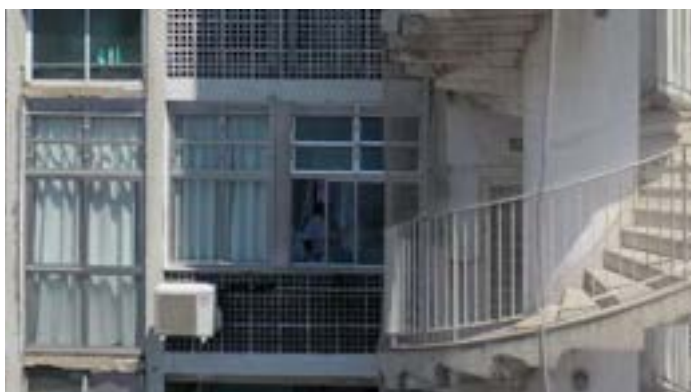
Cobogós substituídos por caixilharia metálica no Trecho 01 da Fachada Sul, Bloco A. FONTE: Drone Way/Instituto Pedra.
