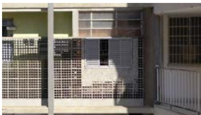
Substituição dos cobogós da Fachada Sul por caixilharia de alumínio, no 5º andar do Bloco E. FONTE: Drone Way/Instituto Pedra.
