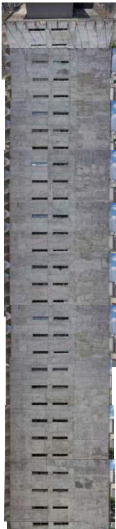
Fotomontagem e mapa de danos da empena Nordeste, realizada com as cenas geradas a partir da filmagem com drone. FONTE: Drone Way/Instituto Pedra.
