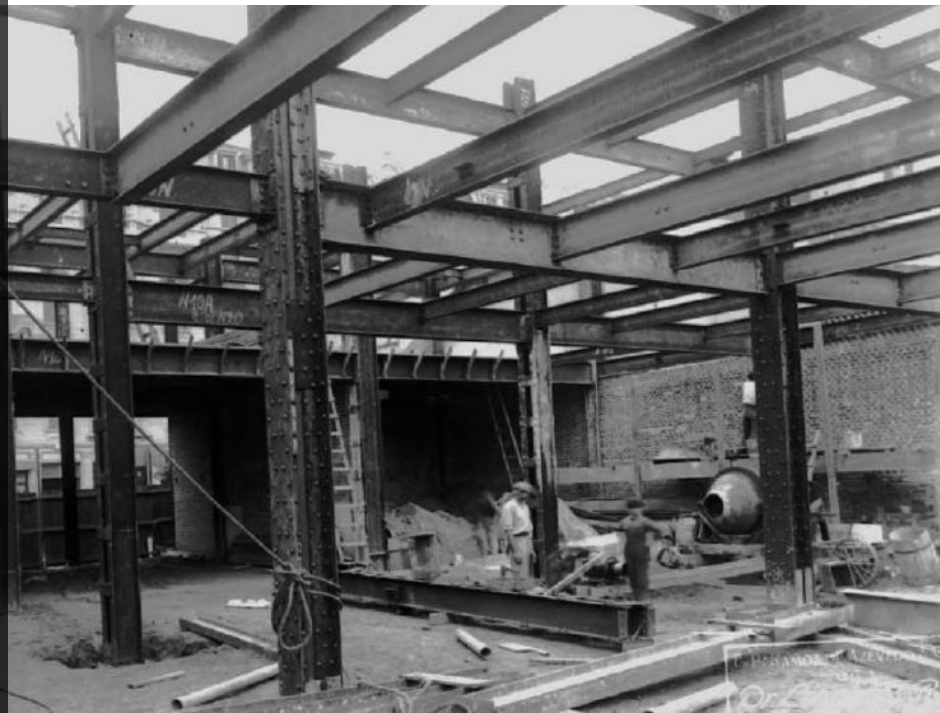
Hotel Columbia Palace durante a construção. Fonte: Coleção Ramos de Azevedo, Acervo FAUUSP
