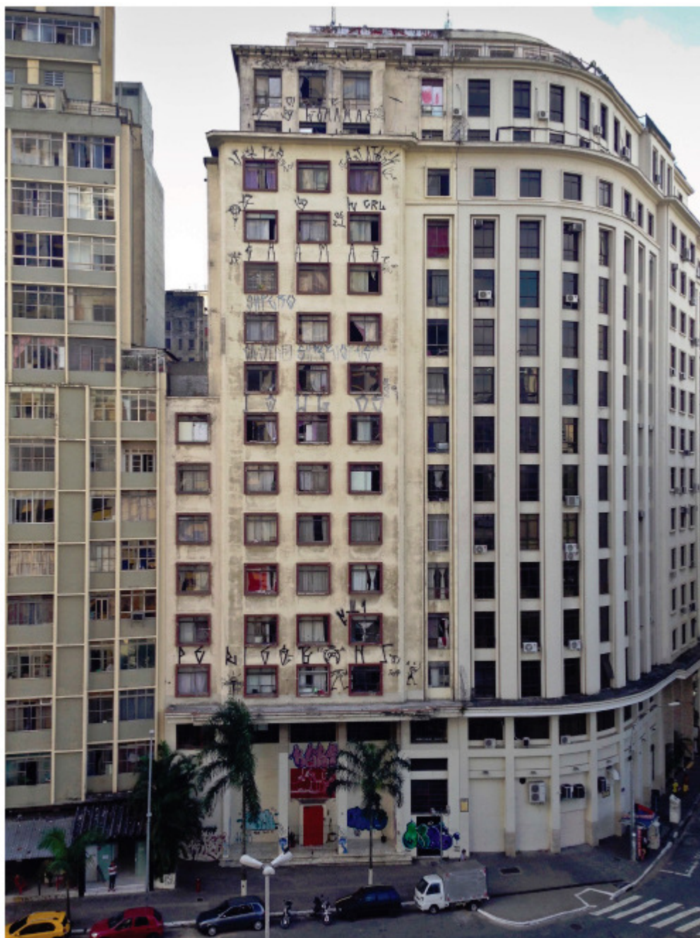
Fachada da Av. Nove de Julho, anterior ao Retrofit
