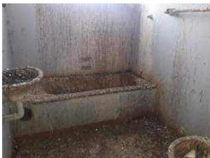
Interior de um banheiro no 8º andar
