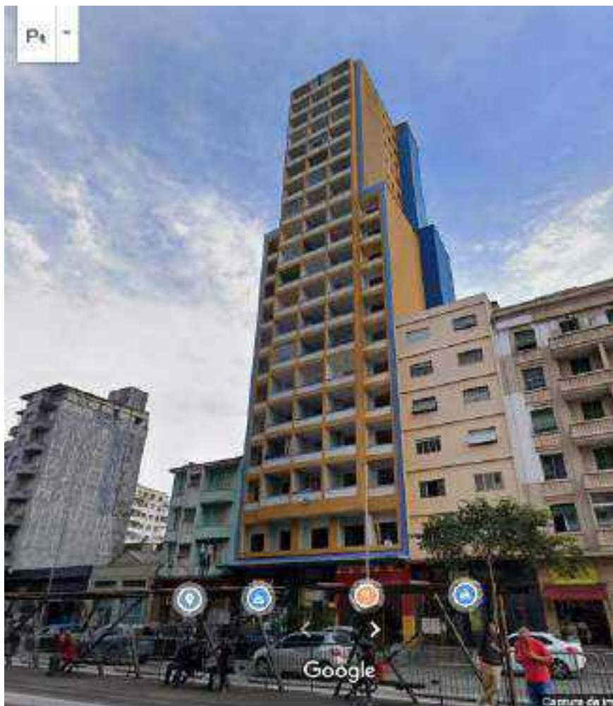
Fachada em processo de revitalização
