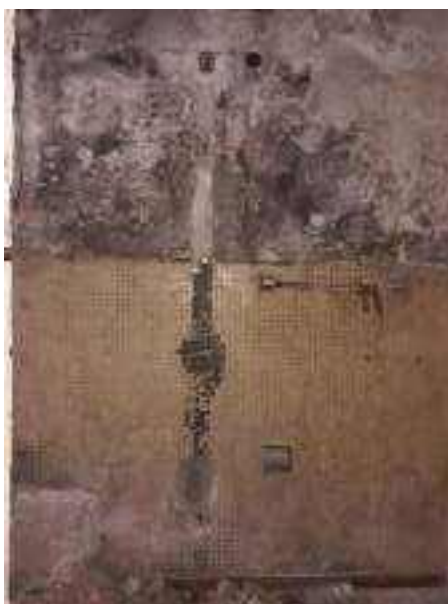
Interior de um banheiro no 6º andar
