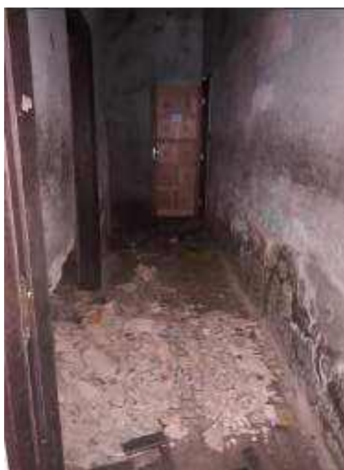
Área de circulação – 03º andar
