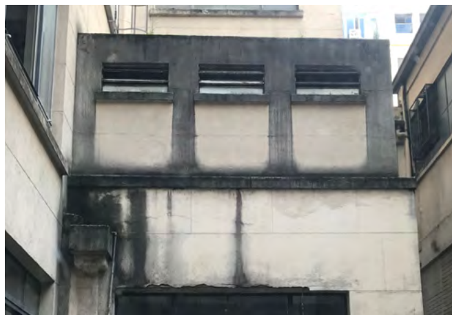
fig 71. Trechos com crosta negra.
