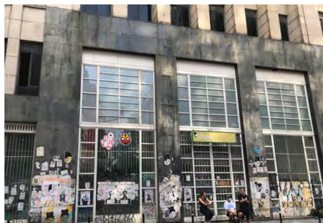
fig 37. Caixilhos de ferro e revestimento em granito preto na fachada frontal. Fonte: Acervo Ambiência Arquitetura e Restauro, 2022.
