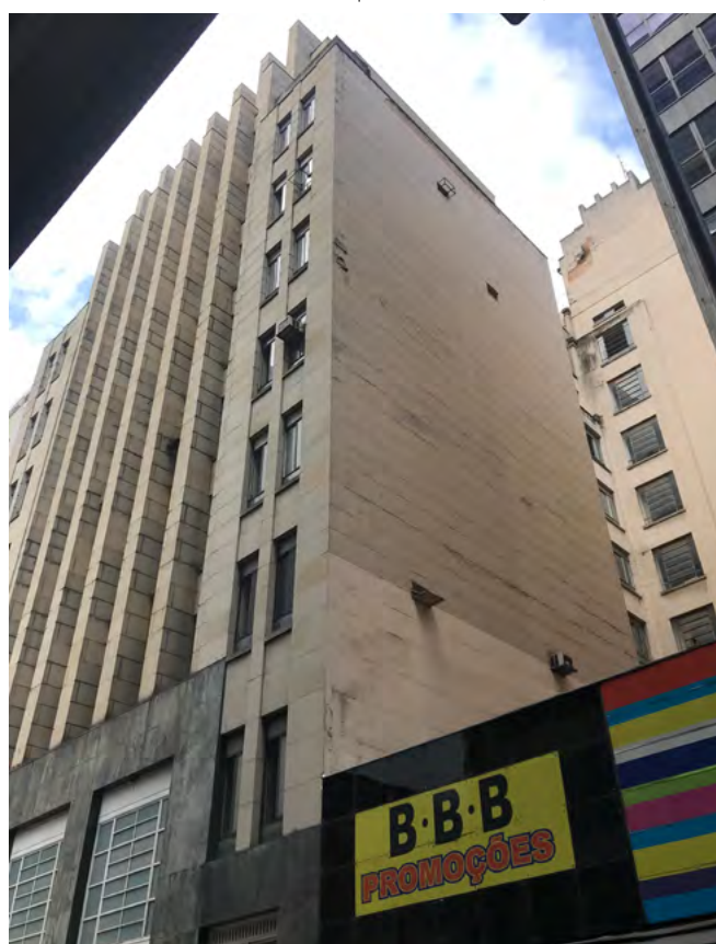
fig 34. Trecho da fachada lateral, revestido com argamassa pintada. Fonte: Acervo Ambiência Arquitetura e Restauro, 2022.
