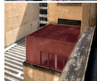
fig 163. Fotos atuais dos volumes construídos posteriormente. Fonte: Autoria Metro Arquitetos.
