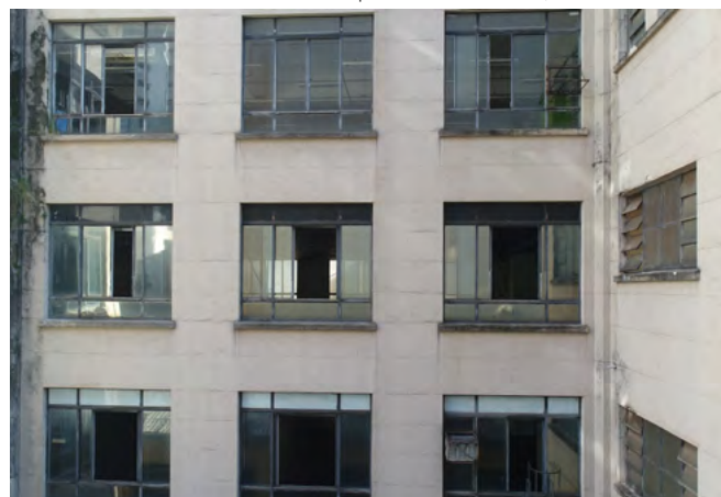
fig 39. Caixilhos de ferro na fachada lateral. Fonte: Acervo Ambiência Arquitetura e Restauro, 2022.
