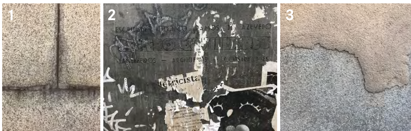
fig 35. Os acabamentos identificados nas fachadas. (1). Granito branco cinzelado (2). Granito preto polido (3). Argamassa pintada. Fonte: Acervo Ambiência Arquitetura e Restauro, 2022.
