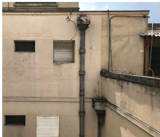
fig 150. As prumadas externas de descida de água pluvial originais. Fonte: Ambiência Arquitetura e Restauro, 2022.
