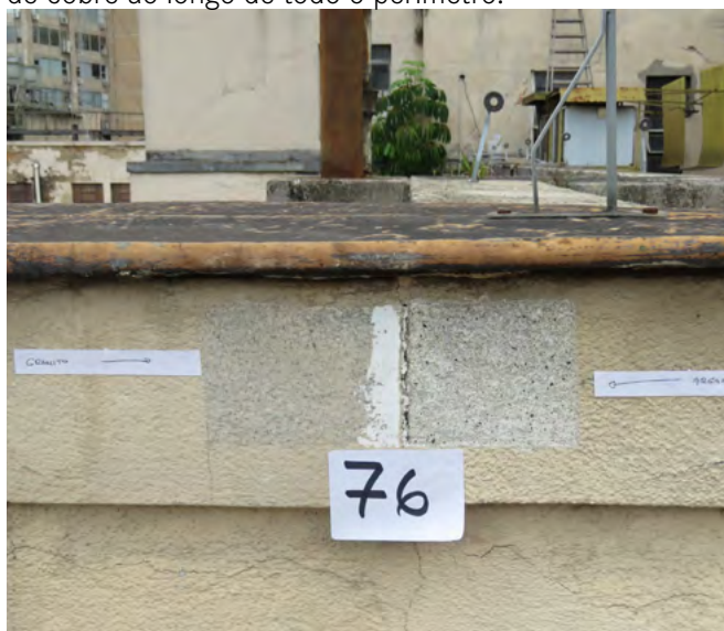
fig 133. Investigação das muretas na cobertura. Fonte: KRM Restaurações, 2022.
