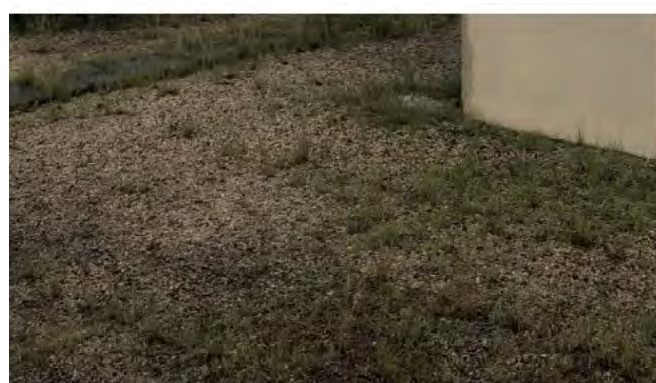
fig 222. Piso existente na cobertura, em seixos. Fonte: Autoria Metro Arquitetos.
