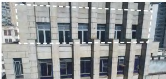
fig 204. Foto da Fachada 01, 9º pavimento.
