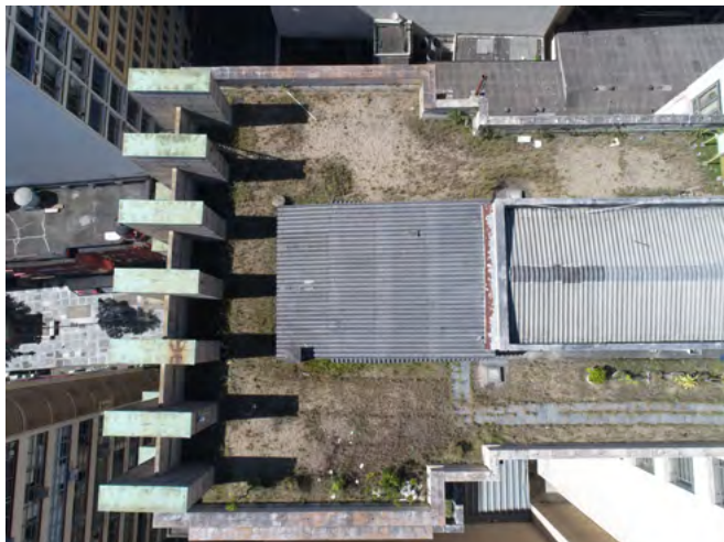
fig 42. Cobertura. Fonte: Acervo Ambiência Arquitetura e Restauro, 2022.
