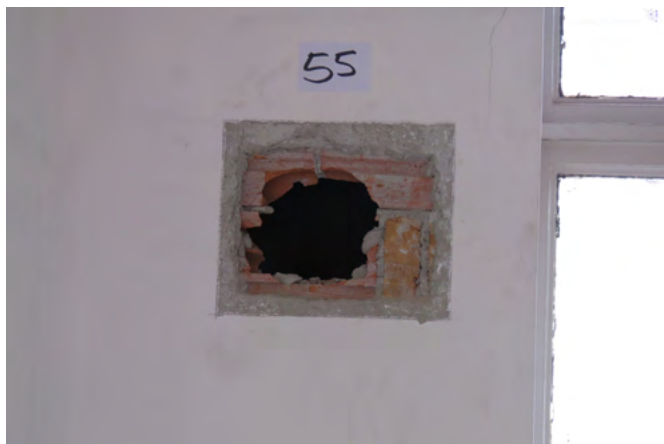
fig 130. Investigação do vão antigamente usado pelo duto de ventilação. Fonte: KRM Restaurações, 2022.
