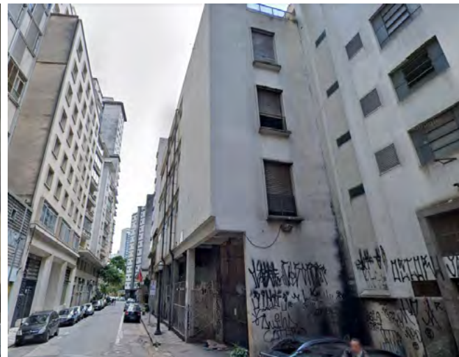
fig 28. Edifício anexo, construído juntamente ao edifício 3.
