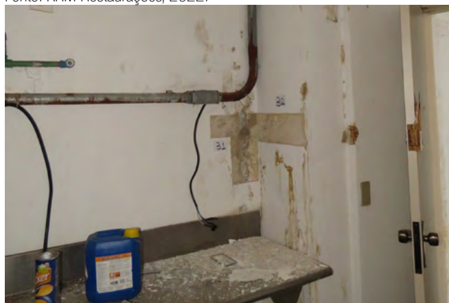
fig 122. Janela 31, indicando o trecho construído posteriormente. Fonte: KRM Restaurações, 2022.
