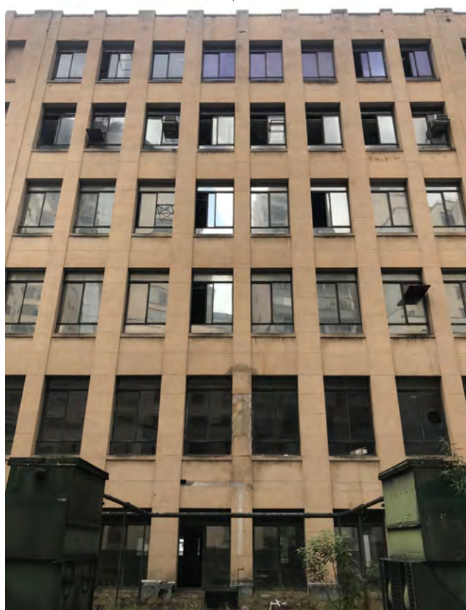
fig 33. Trecho da fachada posterior, revestido com argamassa pintada. Fonte: Acervo Ambiência Arquitetura e Restauro, 2022.
