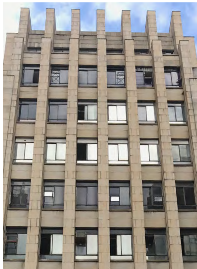
fig 30. Trecho superior da fachada frontal, em granito. Fonte: Acervo Ambiência Arquitetura e Restauro, 2022.
