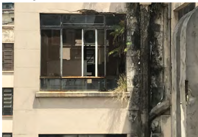
fig 73. Trechos ocupados com colonização biológica.
