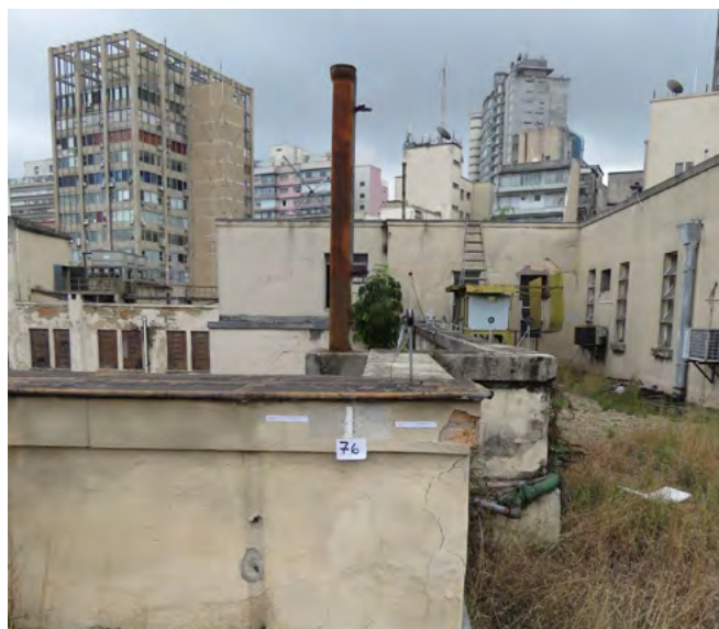
fig 132. Investigação das muretas na cobertura. Fonte: KRM Restaurações, 2022.
