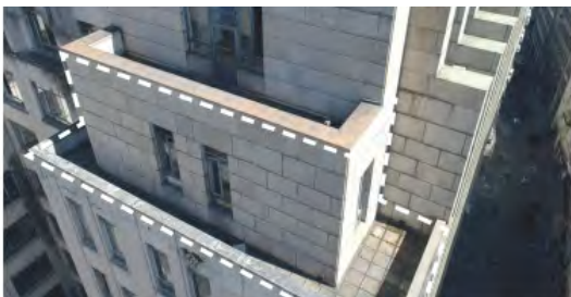
fig 198. Foto da Fachada 03-A, 8º pavimento.
