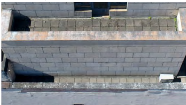
fig 226. Piso existente na cobertura, em placas cimentícias aplicadas sob o contrapiso de concreto. Fonte: Ambiência Arquitetura e Restauro, 2022.
