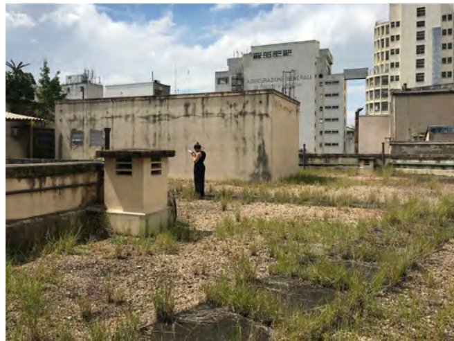
fig 43. Laje do volume anexo. Fonte: Acervo Ambiência Arquitetura e Restauro, 2022.
