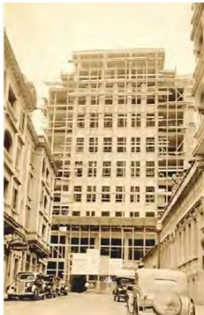
fig 22. Construção do edifício sede da CTB, em 1938. Fonte: Acervo Fundação Telefônica.
