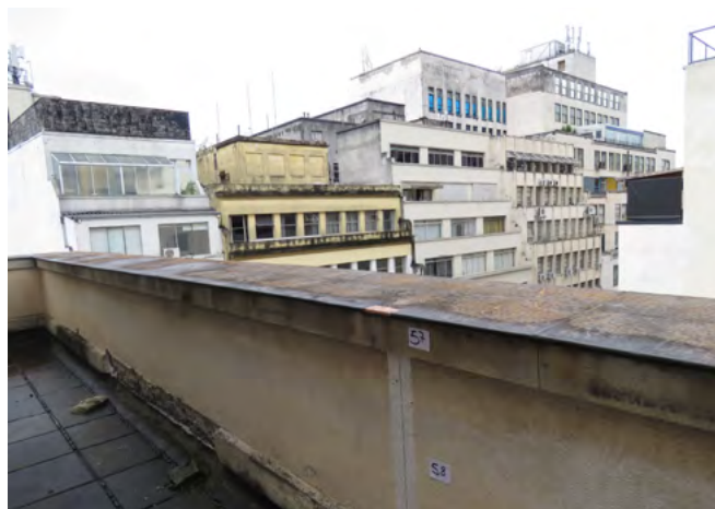
fig 134. Investigação das muretas na cobertura. Fonte: KRM Restaurações, 2022.
