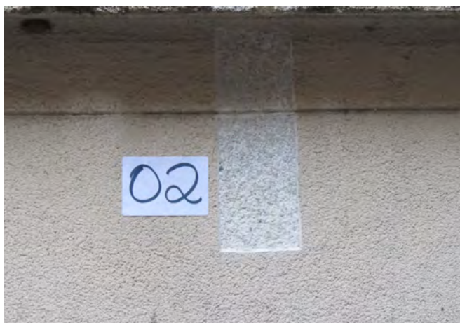
fig 112. Janela 02, correspondente ao acabamento original do edifício, em argamassa raspada sem pintura. Fonte: KRM Restaurações, 2022.
