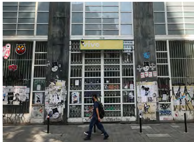
fig 69. Elementos colados no granito do embasamento.
