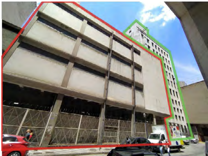
fig 27. Edifício anexo, construído juntamente ao edifício 3.
