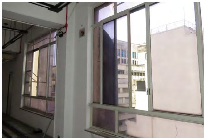
fig 131. Investigação do vão antigamente usado pelo duto de ventilação. Fonte: KRM Restaurações, 2022.
