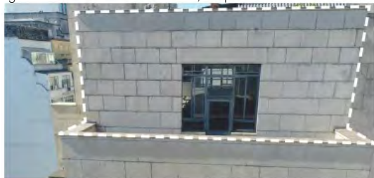
fig 208. Foto da Fachada 04-A, 9º pavimento.
