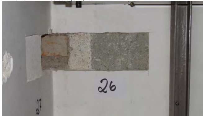
fig 121. Janela 26 e 27 indicando o trecho construído posteriormente. Fonte: KRM Restaurações, 2022.
