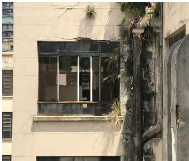
fig 149. As prumadas externas de descida de água pluvial originais. Fonte: Ambiência Arquitetura e Restauro, 2022.
