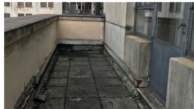
fig 225. Piso existente na cobertura, em placas cimentícias aplicadas sob o contrapiso de concreto. Fonte: Ambiência Arquitetura e Restauro, 2022.
