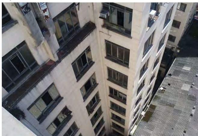
fig 38. Caixilhos de ferro na fachada lateral. Fonte: Acervo Ambiência Arquitetura e Restauro, 2022.
