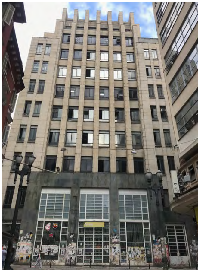
fig 29. Vista da fachada frontal. Identifica-se o granito preto no embasamento e o granito branco a partir do primeiro pavimento. Fonte: Acervo Ambiência Arquitetura e Restauro, 2022.
