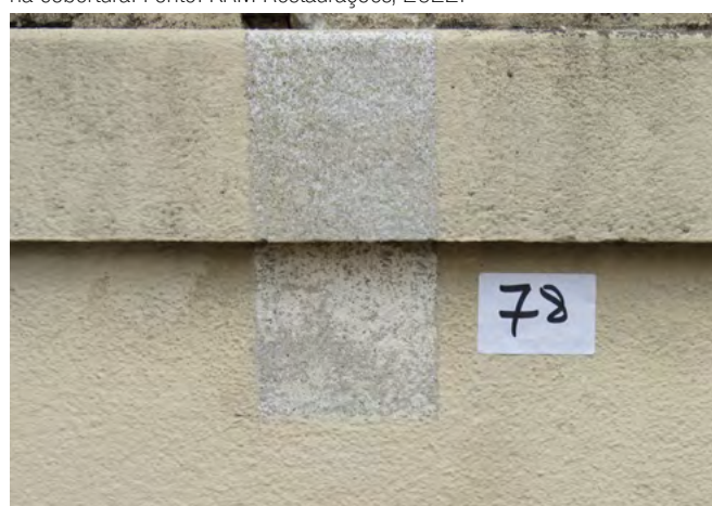
fig 138. Investigação do completamento das muretas da fachada frontal na cobertura. Fonte: KRM Restaurações, 2022.
