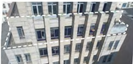
fig 197. Foto da Fachada 01, 8º pavimento.
