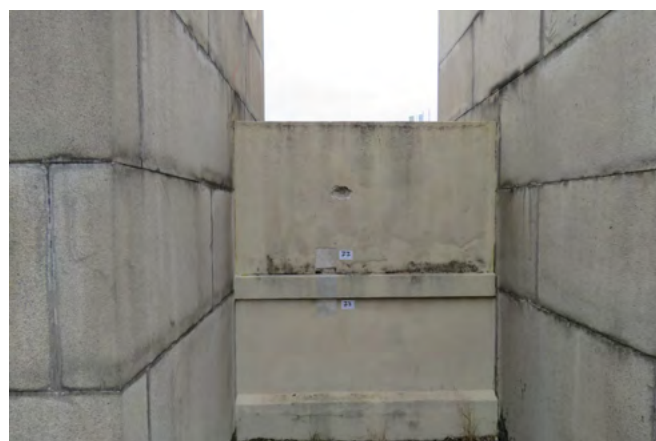
fig 136. Investigação do completamento das muretas da fachada frontal na cobertura. Fonte: KRM Restaurações, 2022.
