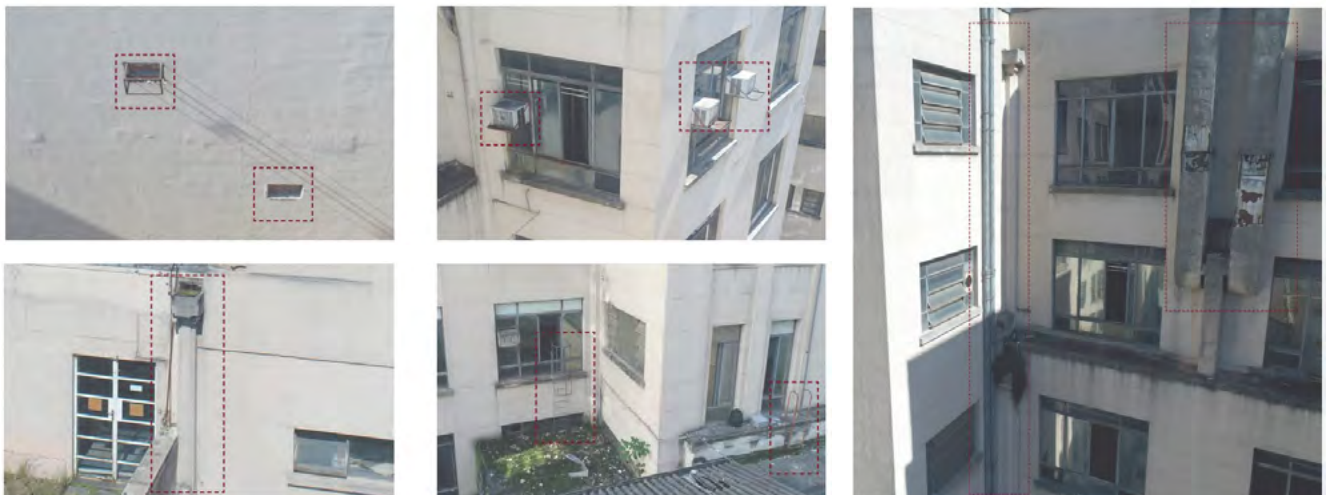
fig 151. Exemplos de instalações espúrias incluída no conjunto de remoções gerais, como escadas, instalações de ar condicionado e dutos e condutas externos. Fonte: Metro Arquitetos, 2022.
