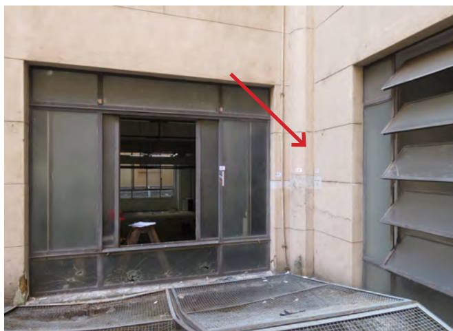
fig 119. Janela 05, trecho de intervenção posterior. Fonte: KRM Restaurações, 2022.
