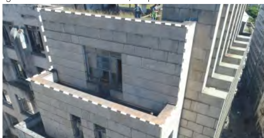
fig 207. Foto da Fachada 03-A, 9º pavimento.
