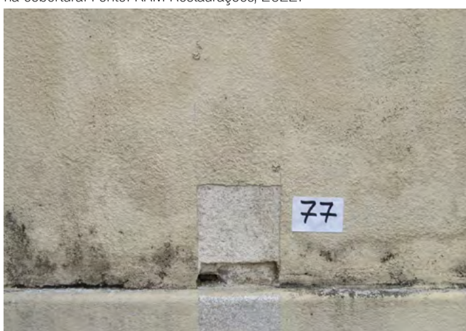
fig 137. Investigação do completamento das muretas da fachada frontal na cobertura. Fonte: KRM Restaurações, 2022.
