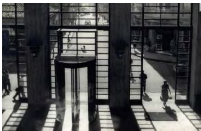
fig 23. Vista interna do átrio de acesso pela rua Sete de Abril, em 1938. Fonte: Acervo Fundação Telefônica.
