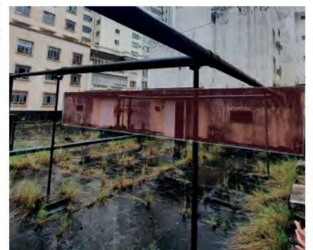
fig 166. Fotos atuais do volume técnico, construído posteriormente. Fonte: Autoria Metro Arquitetos.
