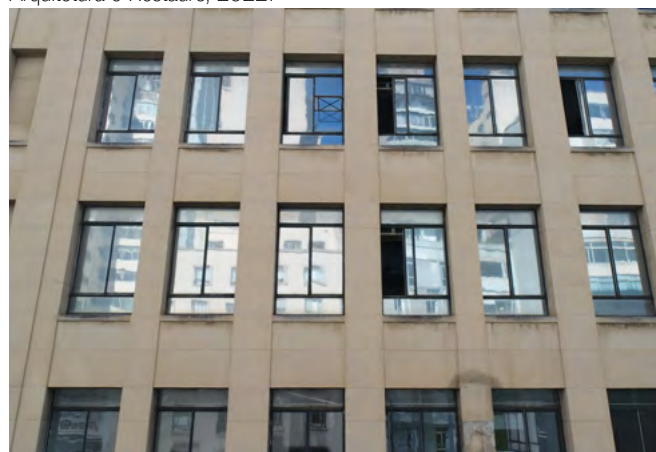
fig 41. Caixilhos de ferro na fachada lateral. Fonte: Acervo Ambiência Arquitetura e Restauro, 2022.
