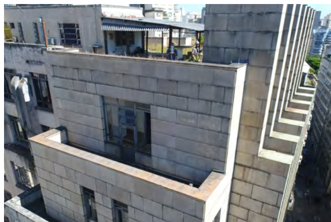
fig 32. Revestimento empregado nos trechos superiores da fachada frontal. Fonte: Acervo Ambiência Arquitetura e Restauro, 2022.
