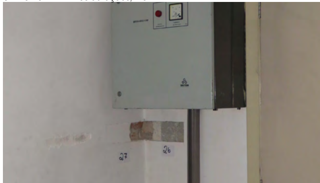
fig 124. Janela 27, indicando o trecho construído posteriormente. Fonte: KRM Restaurações, 2022.
