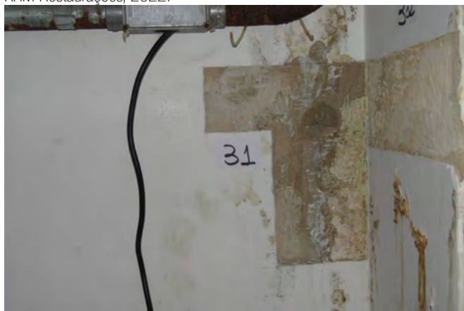
fig 123. Janela 31 indicando o trecho construído posteriormente. Fonte: KRM Restaurações, 2022.
