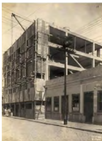
fig 13. O edifício 3 em fase de construção, em 1916. Fonte: Acervo Telefônica.
