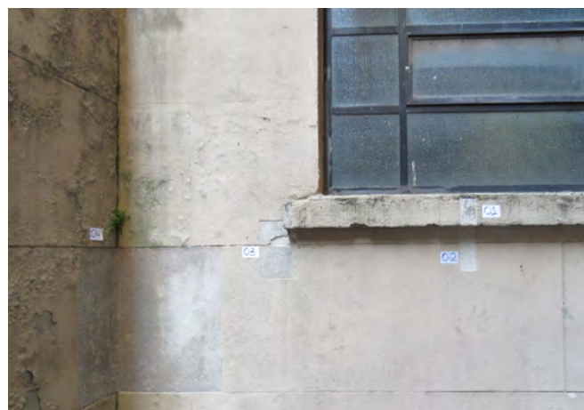
fig 113. Janela 02, 03 e 04, correspondentes ao acabamento original do edifício, em argamassa raspada sem pintura. Fonte: KRM Restaurações, 2022.
