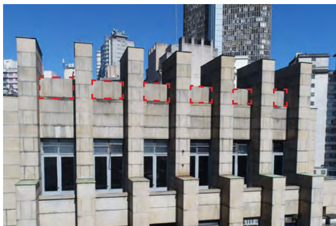
fig 141. Investigação do completamento das muretas da fachada frontal na cobertura. Fonte: KRM Restaurações, 2022.
