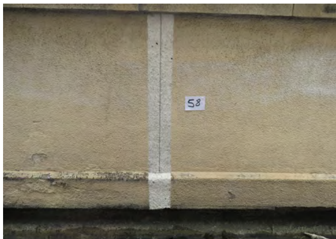
fig 135. Investigação das muretas na cobertura. Fonte: KRM Restaurações, 2022.
