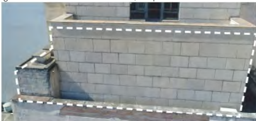
fig 199. Foto da Fachada 034-A, 8º pavimento.
