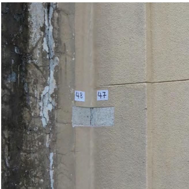
fig 128. A distinção identificada entre o volume original e o anexo construído posteriormente. Fonte: KRM Restaurações, 2022.
