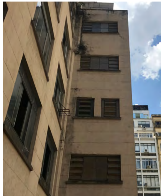
fig 187. Esquadrias atuais na fachada 3A.
