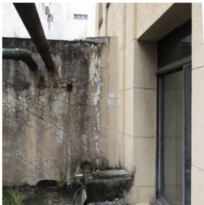
fig 129. A distinção identificada entre o volume original e o anexo construído posteriormente. Fonte: KRM Restaurações, 2022.
